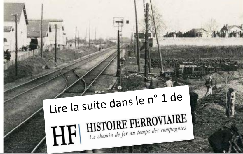
5 - Quelques mois plus tard après la prise de la vue 4, le poste Saxby en bois est démolé. Dans cette zone, la voie 3 a temporairement disparu, ainsi que la jonction avec la direction de Périgueux depuis les voies 2 et 1. On comprend que le raccordement avec la ligne principale Paris-Bordeaux est déporté provisoirement plus au sud, en gare. Sur la grande ligne principale, reste en place la jonction entre les voies 1 et 2. Le carré sur voie 1, vu de dos, aperçu sur la vue précédente et ici bien visible, est fermé. Le sémaphore, cantonnant la direction de Périgueux, est déposé.
