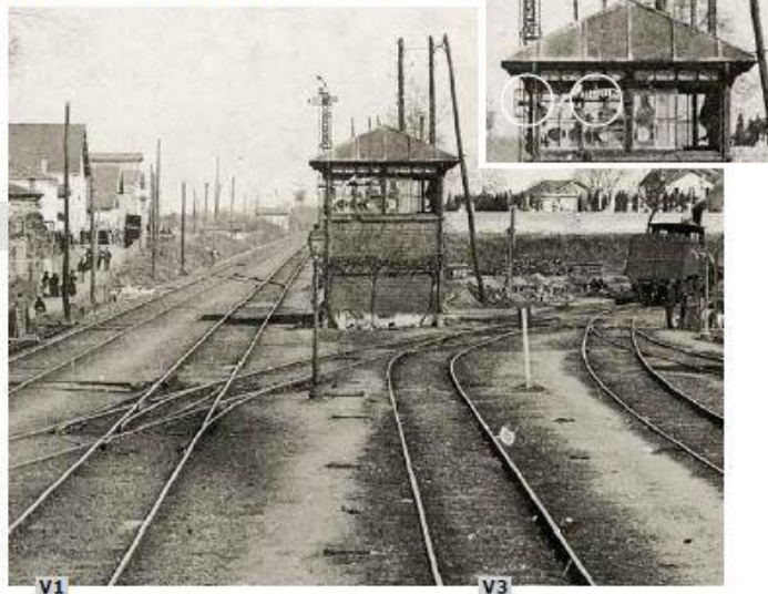
4 - Vue de la situation avant les travaux, à comparer à la vue 1 de la page précédente. La ligne vers Périgueux, à voie unique, part vers la droite, où se trouve une locomotive, probablement en train de manœuvrer et passer d'une voie à l'autre. Par le biais des jonctions et branchements, la direction de Périgueux forme tiroir. Elle est accessible indifféremment par chacune des 3 voies. Le poste Saxby, d'un type classique au XIX e siècle en bois, est installé au centre de la bifurcation. Le réservoir d'eau sur la droite a une capacité de 124 m 3 .
