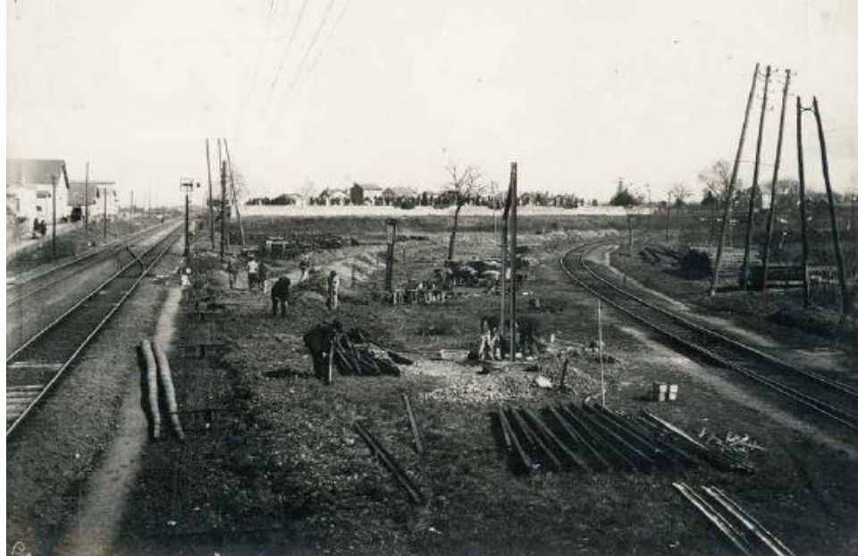
5 - Quelques mois plus tard après la prise de la vue 4, le poste Saxby en bois est démolé. Dans cette zone, la voie 3 a temporairement disparu, ainsi que la jonction avec la direction de Périgueux depuis les voies 2 et 1. On comprend que le raccordement avec la ligne principale Paris-Bordeaux est déporté provisoirement plus au sud, en gare. Sur la grande ligne principale, reste en place la jonction entre les voies 1 et 2. Le carré sur voie 1, vu de dos, aperçu sur la vue précédente et ici bien visible, est fermé. Le sémaphore, cantonnant la direction de Périgueux, est déposé.
