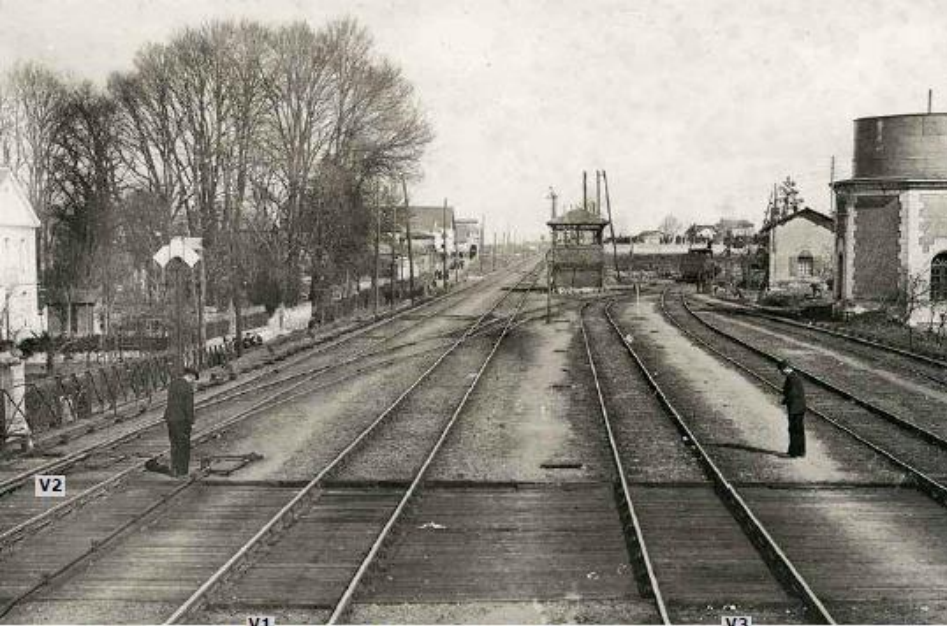
4 - Vue de la situation avant les travaux, à comparer à la vue 1 de la page précédente. La ligne vers Périgueux, à voie unique, part vers la droite, où se trouve une locomotive, probablement en train de manœuvrer et passer d'une voie à l'autre. Par le biais des jonctions et branchements, la direction de Périgueux forme tiroir. Elle est accessible indifféremment par chacune des 3 voies. Le poste Saxby, d'un type classique au XIX e siècle en bois, est installé au centre de la bifurcation. Le réservoir d'eau sur la droite a une capacité de 124 m 3 .
