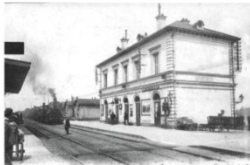
Le bâtiment de Brétigny est construit en 1865 sur un nouvel emplacement. Il remplace le BV d'origine, mal situé entre une tranchée et un remblai, dont le site ne permettait pas l'établissement de la bifurcation. Analogue au BV de Châteaudun, ce bâtiment sera profondément remanié et agrandi en 1904 lors du passage de la ligne d'Orléans à 4 voies pour prendre la configuration du BV connu de nos jours. CPA DR, collection Daniel Vauvillier.
