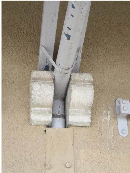
[ph. 51] Vielmur (81) Descente des gouttières.- MV
