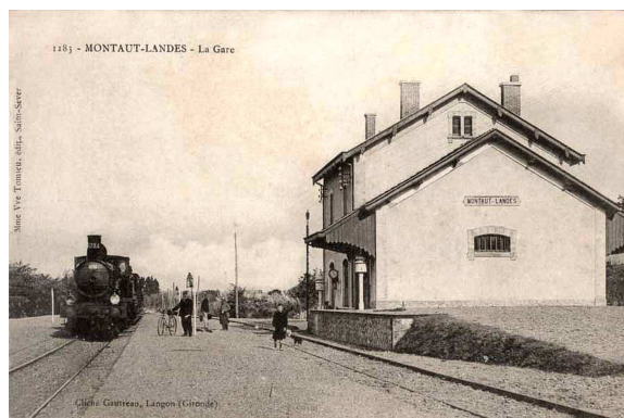
[ph. 58] Montaut (40) Fenêtre du pignon HM.- cpa
