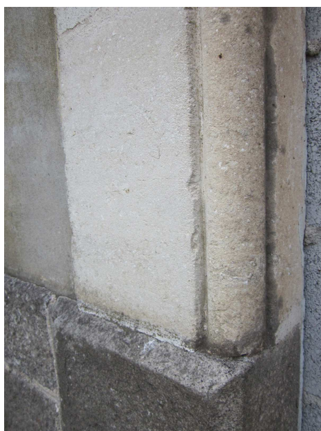
[ph. 13] Labastide-Rouairoux (81) Moulure d'un chambranle.- MV
