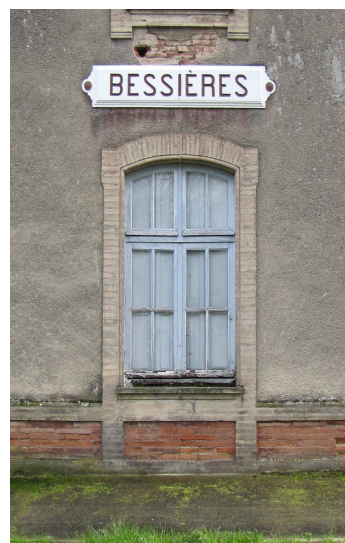
[ph. 17] Bessières (31) Construction en briques.- MV
