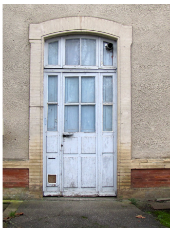
[ph. 11] Bessières (31) Porte des bureaux.- MV
