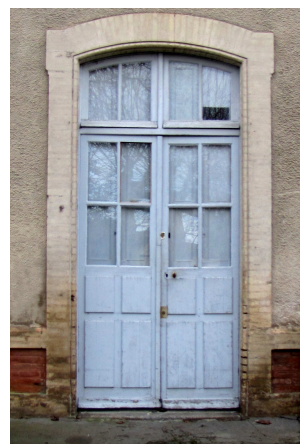
[ph. 12] Bessières (31) Porte du vestibule.- MV
