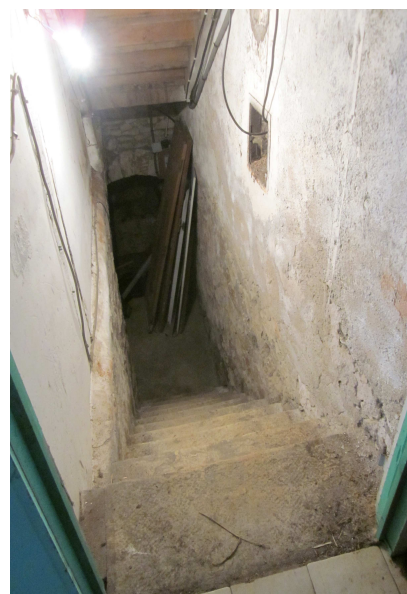
ph. 5] St-Etienne-d'Albagnan (34) Escalier de la cave.- MV
