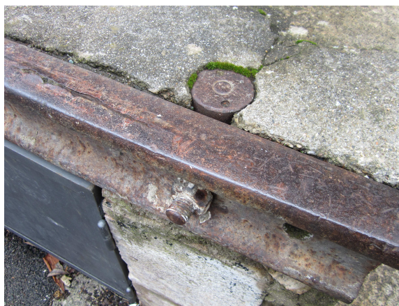
[ph. 44] Courniou (34) Rail en bordure de quai.- MV
